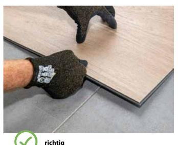
**Hinweis:** Verlegen Sie so, dass die Verbindungen des Click-Bodens nicht deckungsgleich über Fugen im Untergrund, wie z. B. Keramikfliesen verlaufen.
